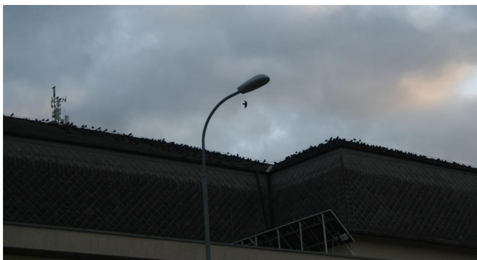
Obr. 5: Budova SPŠS, na kterou se kavky slétají před společným odletem na nocoviště.
