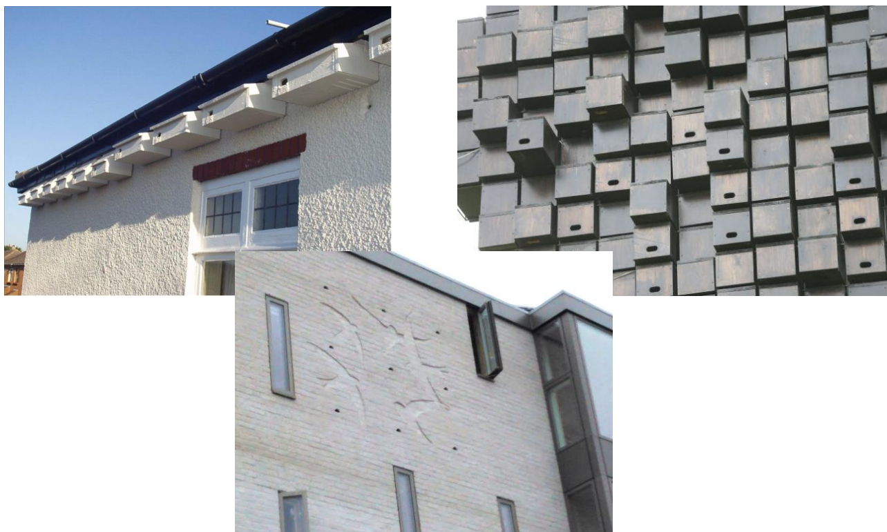
Obr. 2, 3 a 4: Ukázky opravených nebo nově postavených moderních budov vhodných pro hnízdění rorýsů.
